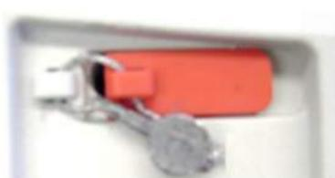
Блокировка включена и опломбирована проволочной пломбой
